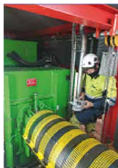
Jakub provádí kontrolu vibrací předního ložiska generátoru
