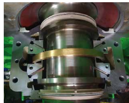
Inspekce obou ložisek, včetně rozleštění ložiskových kamenů, čištění olejového zásobníku od sedlin a výměna labyrintových těsnění
